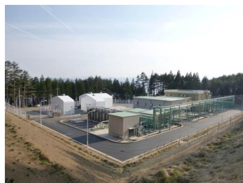
新設した高台部全景(平成 26 年 4 月撮影)
