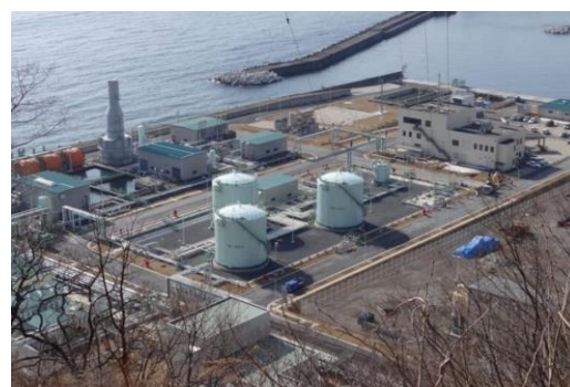
復旧した地上部全景(平成 25 年 3 月撮影)
