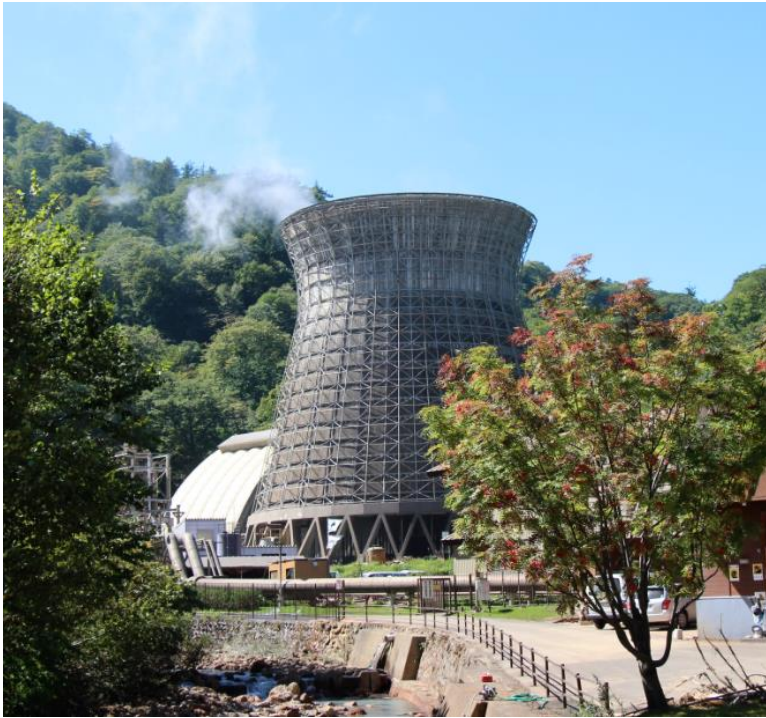
松川地熱発電所の外観(撮影:JOGMEC)
