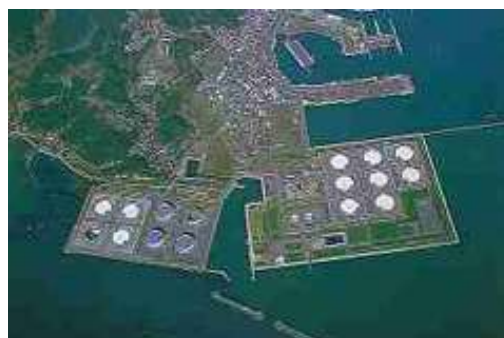
出火のあった秋田国家石油備蓄基地(全景)
