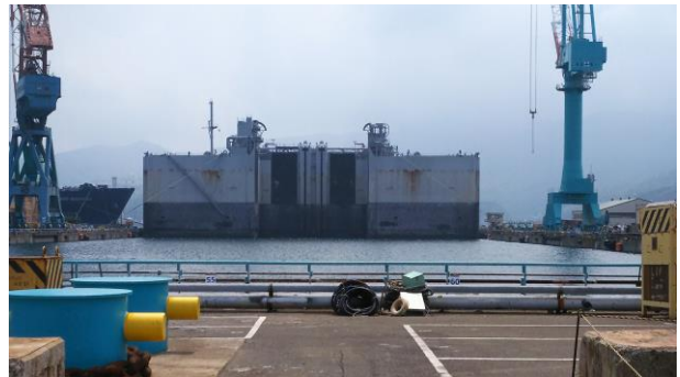
入渠開始(09:45)、入渠完了(11:20)
