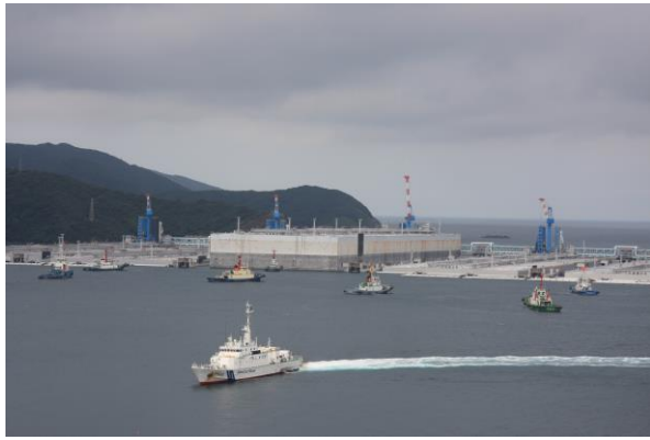
曳航船配置完了・引出し作業開始(7月26日10:00)
