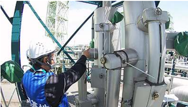
訓練開始前の配管満液を確認
